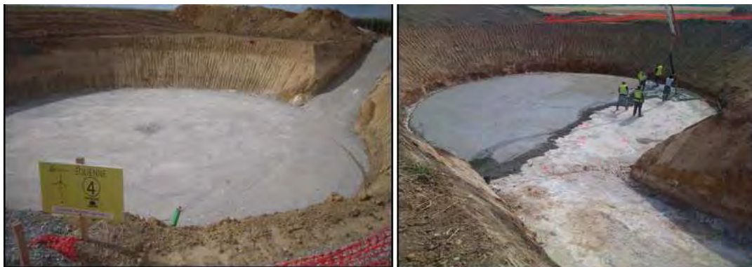
Photographie 5 : Mise en œuvre du béton de propreté
