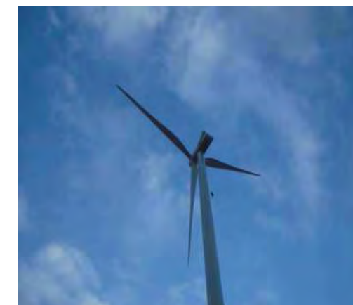
Photographie 13 : Finalisation de l'assemblage des pâles
