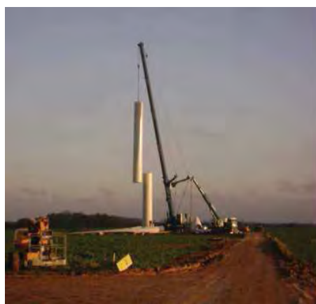
Photographie 12 : Assemblage du mât
