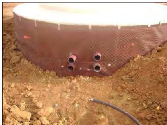
Photographie 11 : Raccordement des réseaux sur le socle de l'éolienne
