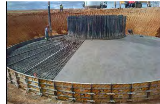
Photographie 7 : Opération de coulage de la semelle béton
